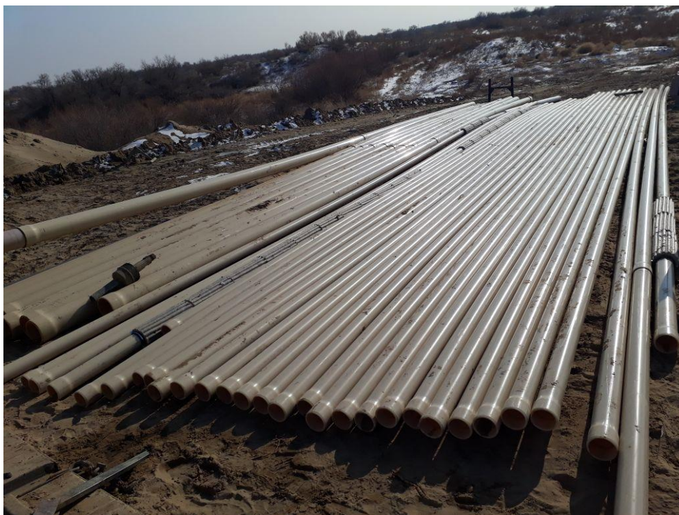
3 сурет – Жерасты сілтілеу тәсілінде қолданылатын сору және жіберу ұңғымалары
